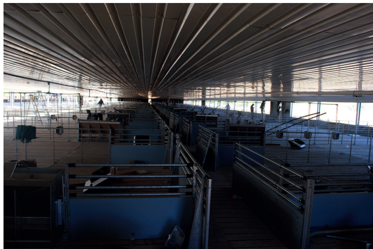
Montaż wewnętrzny trwa
